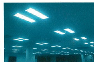
人感センサーを備えて明暗調光するLED照明。
